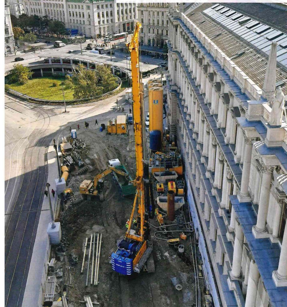
© Bauer Spezialtiefbau GmbH (3)
