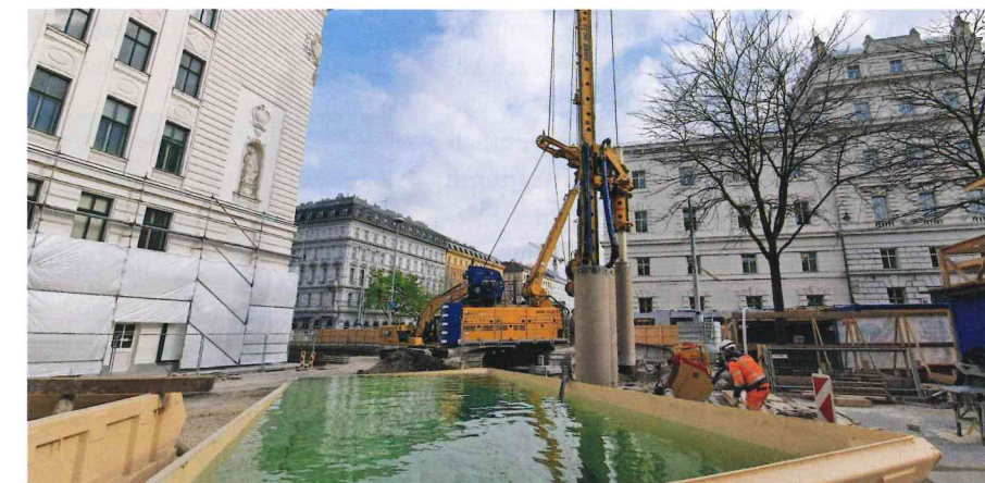
Beim Baulos U5/2 Schacht Frankplatz Nord bohrt eine Bauer BG 39 in die Tiefe.
