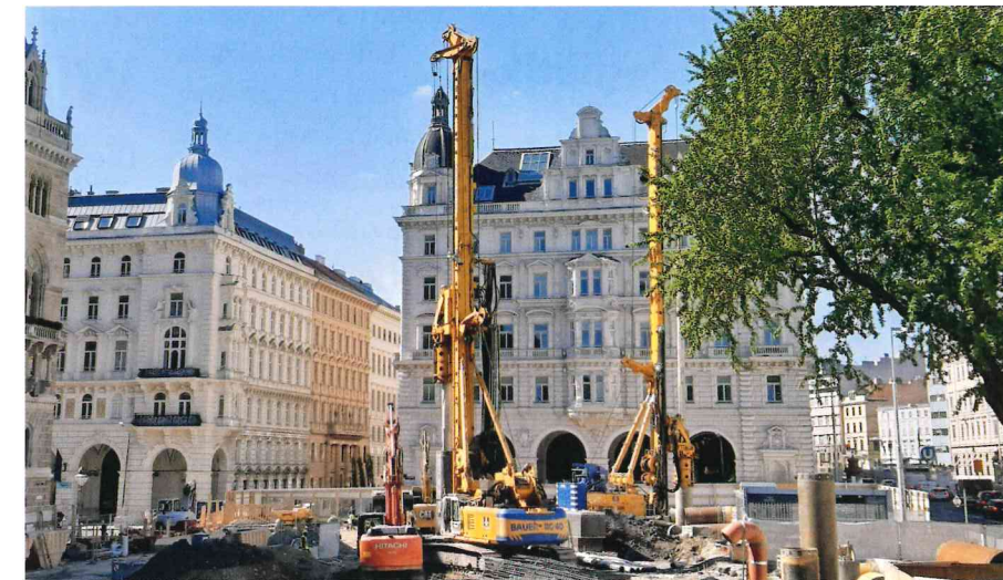
Beim Baulos U2/22 Schacht Friedrich-Schmidt-Platz sind eine Bauer BG 45 und eine Bauer BG 40 im Einsatz.
